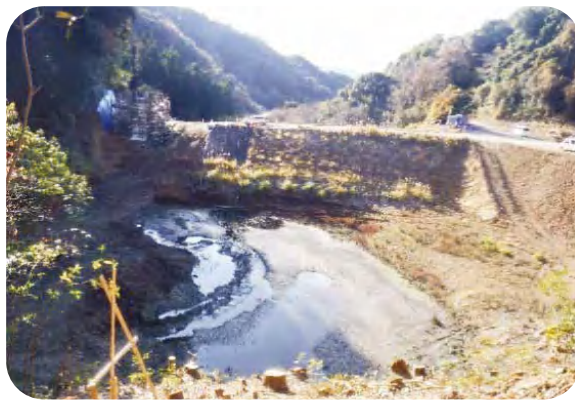
乙見ため池改修の様子
