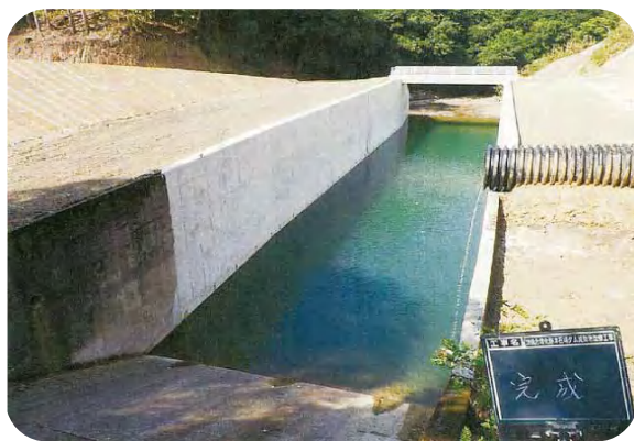
石場ダムの減勢池 改修完了
